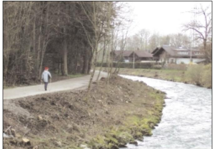
*Ein weiterer Schritt zum Hochwasserschutz in Bergheim: An der Uferböschung entlang der Fischach wurden die Bäume entfernt. Damit kann der Fluss mehr Wasser abtransportieren. Aus optischen Gründen wurden die Bäume auf der Uferkrone stehen gelassen.*
